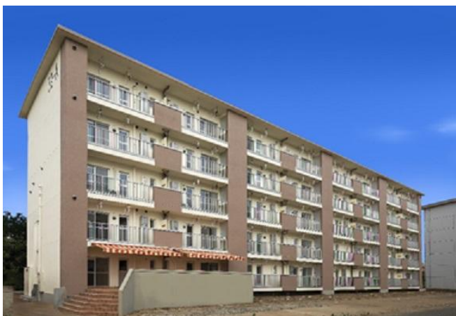
群馬県広瀬第二県営住宅の外観(画像:群馬県)
